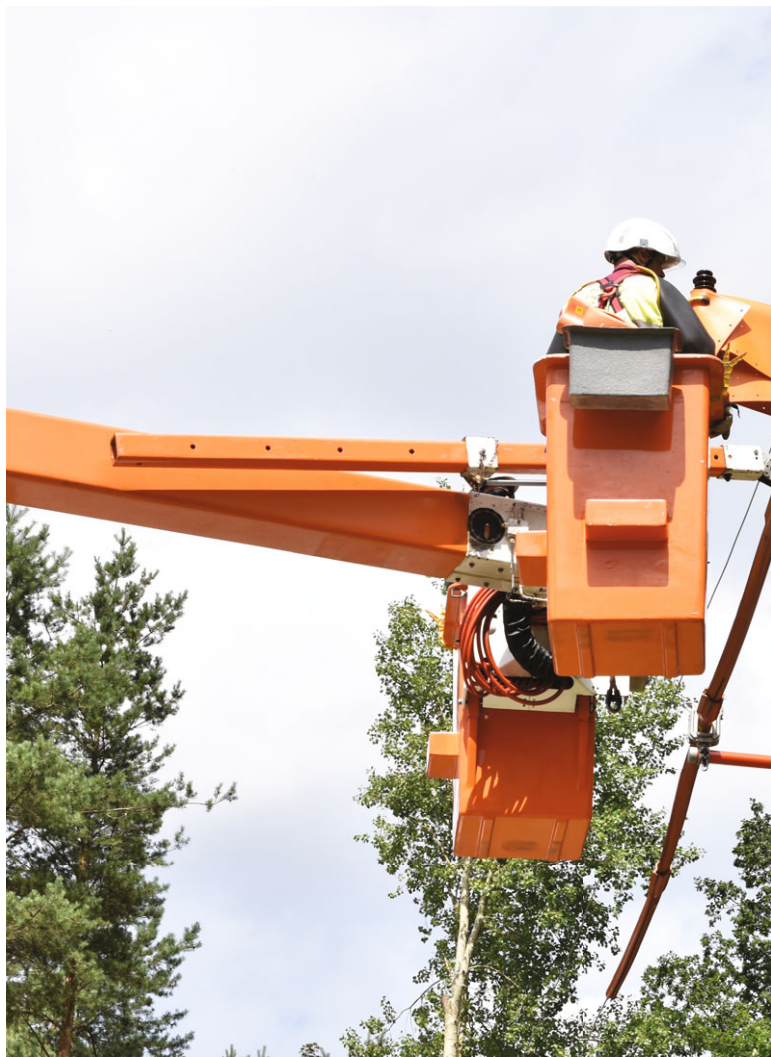
Energa-Operator, Realizacja prac pod napięciem
