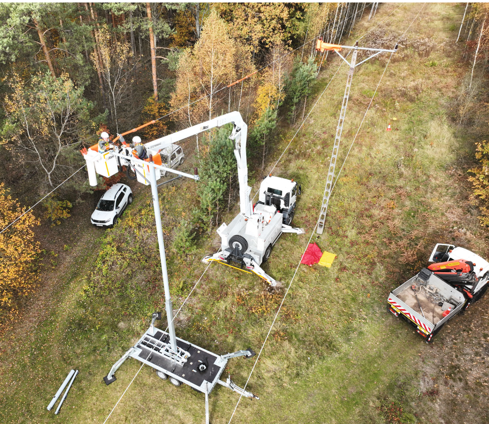
TAURON Dystrybucja, Mobilny słup kompozytowy wspiera prace pod napięciem, umożliwiając wymianę elementów i całych konstrukcji słupów SN
