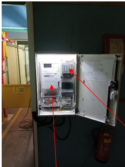
Licznik energii Landis+Gyr typ: E660 z analizatorem jakości energii
