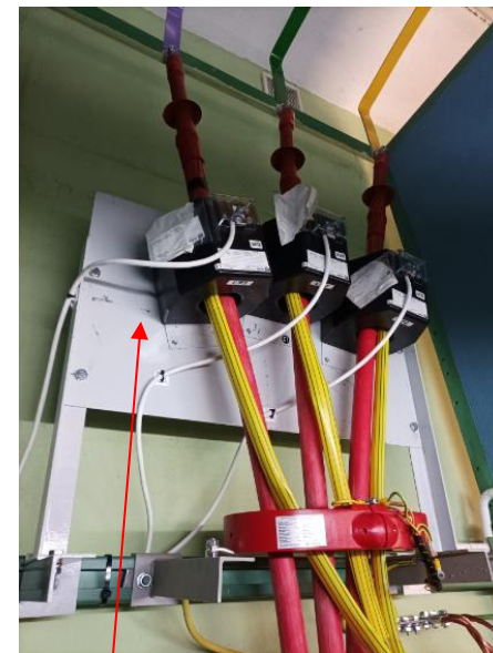
Przekładniki prądowe typu: 1PRK-6 Zelisko, klasa 0,2s
