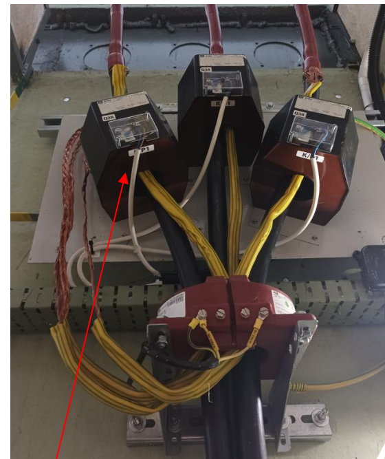
Przekładniki prądowe typu: 1PRK-6 Zelisko, klasa 0,2s
