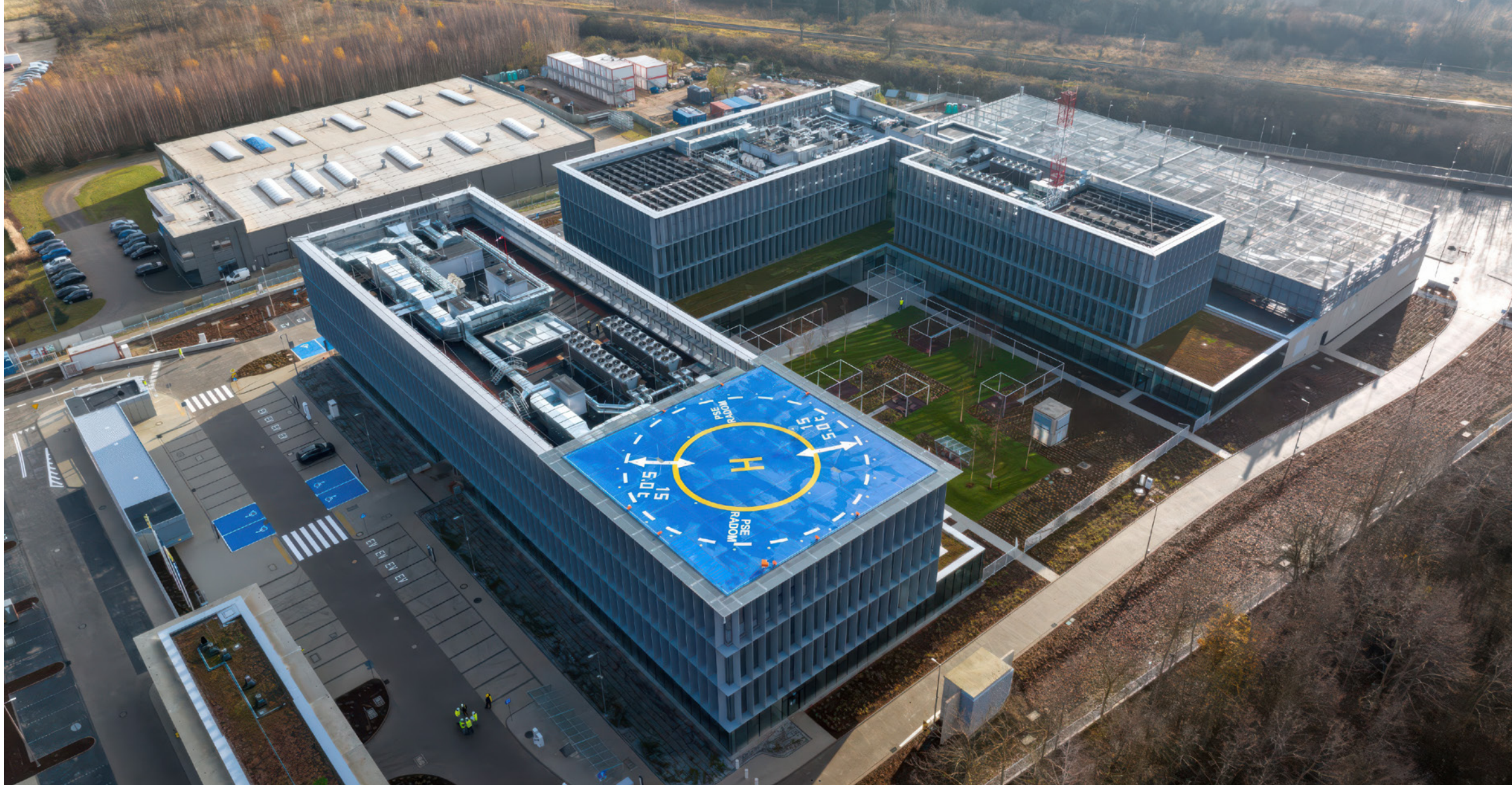
W nowych budynkach PSE w Radomiu będzie zlokalizowana serwerownia systemu CSIRE. fot. PSE
