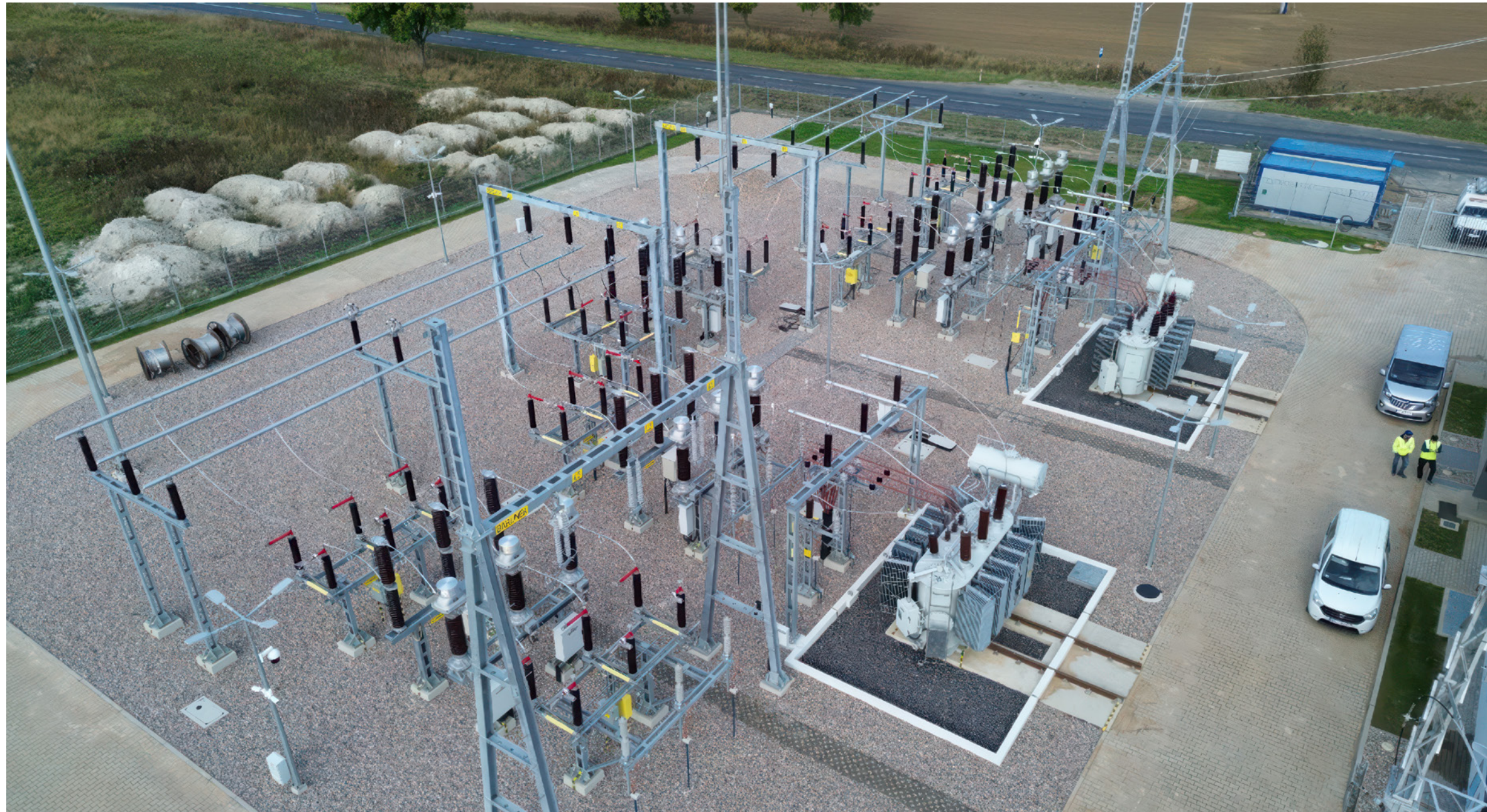
Przebudowa stacji 110 SN Mostkowo fot. Enea Operator
