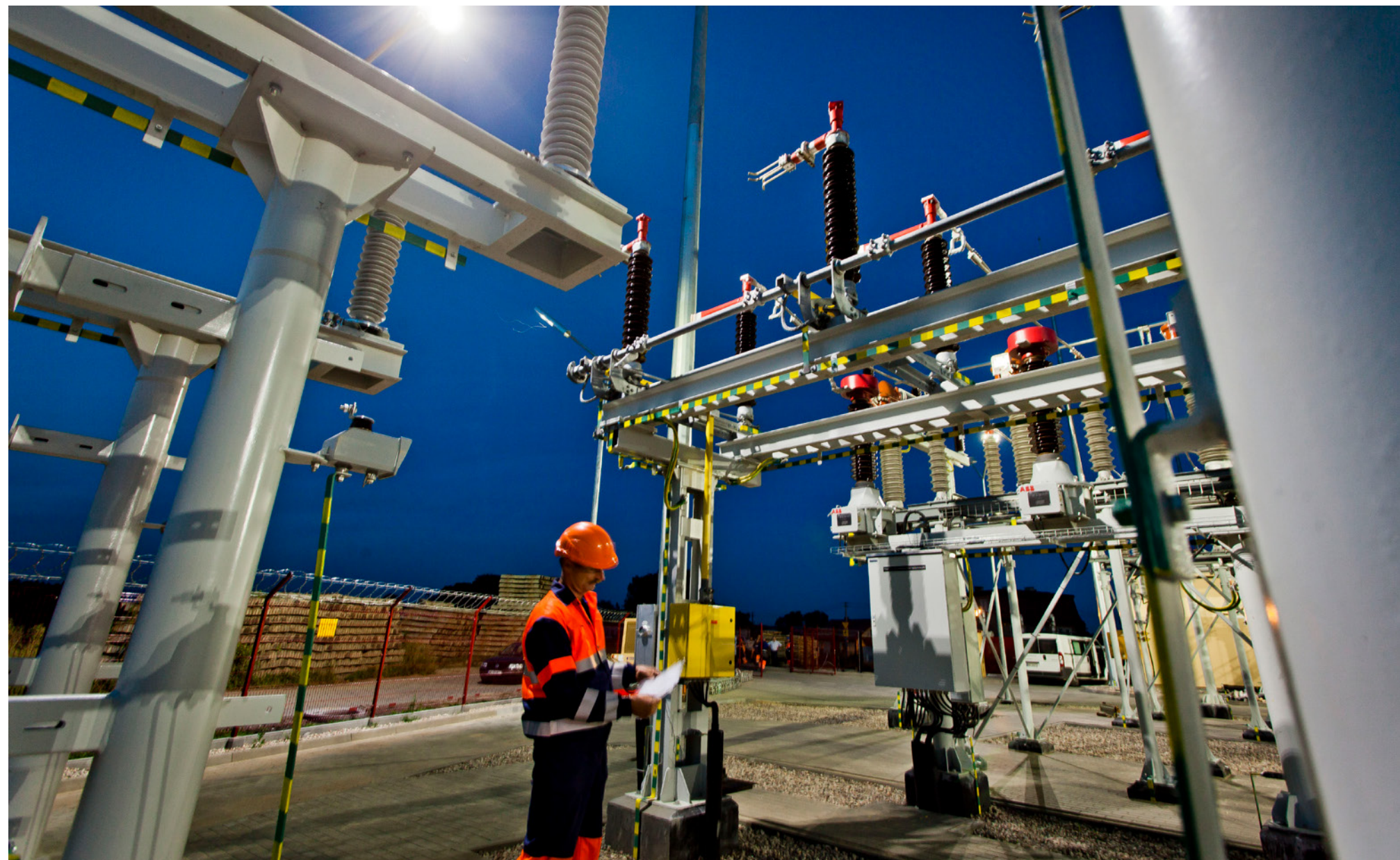
Oględziny rozdzielni napowietrznej 110 kV (weryfikacja stanu położenia odłącznika) na podstacji trakcyjnej, fot. PGE Energetyka Kolejowa
