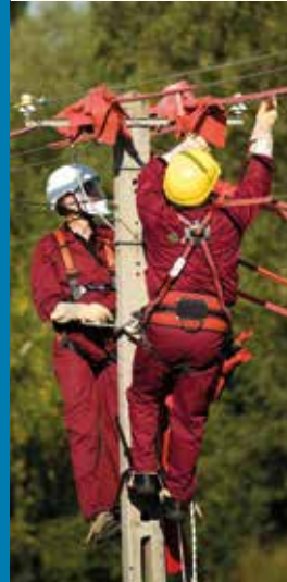
ENERGA-OPEATOR, PRACE POD NAPIĘCIEM NA SIECI nn
