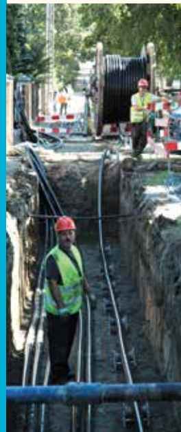
ENERGA-OPERATOR, UKŁADANIE KABLA WYSOKIEGO NAPIĘCIA
